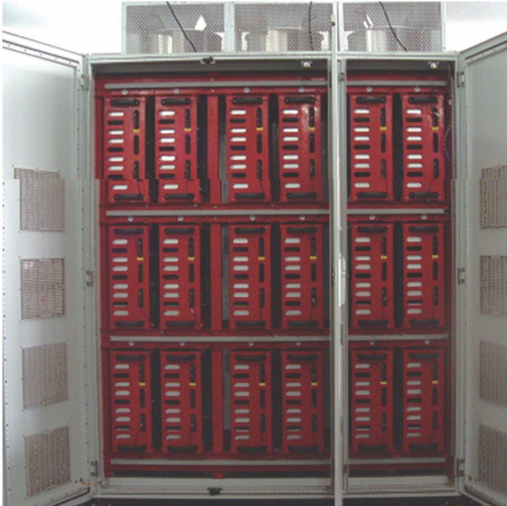
图 4.8 功率柜中单元的排布图
