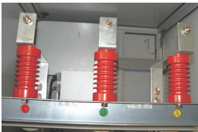
图 7.8 三相主电缆连接端子
