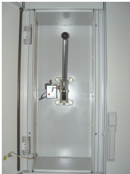
图 6.2 隔离开关闭合时操作杆位置
